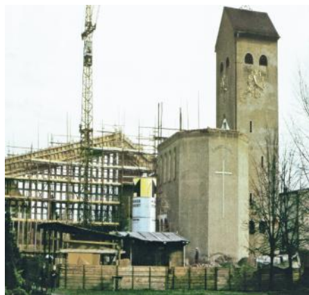
Die neue Kirche im Rohbau
